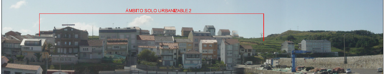
VISTA PANORÁMICA DENDE O DIQUE
